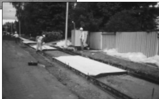
Figure 2. Construction d'un trottoir en béton sur terre-plein.
