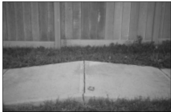
Figure 3. Soulèvement (inclinaison) d'une section de trottoir rigide.
