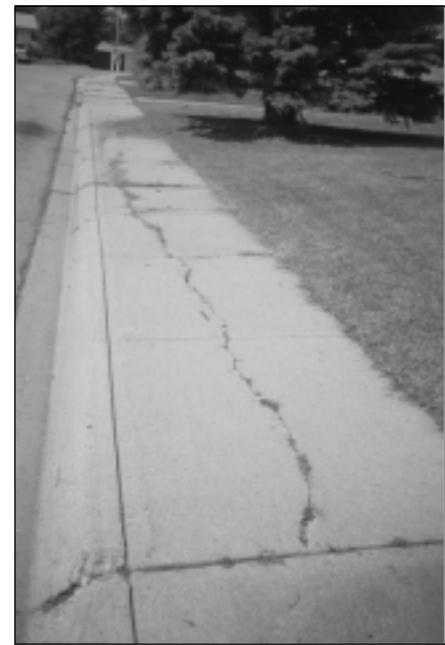
Figure 6. Les fissures longitudinales apparaissent d'ordinaire au tiers central du trottoir.
