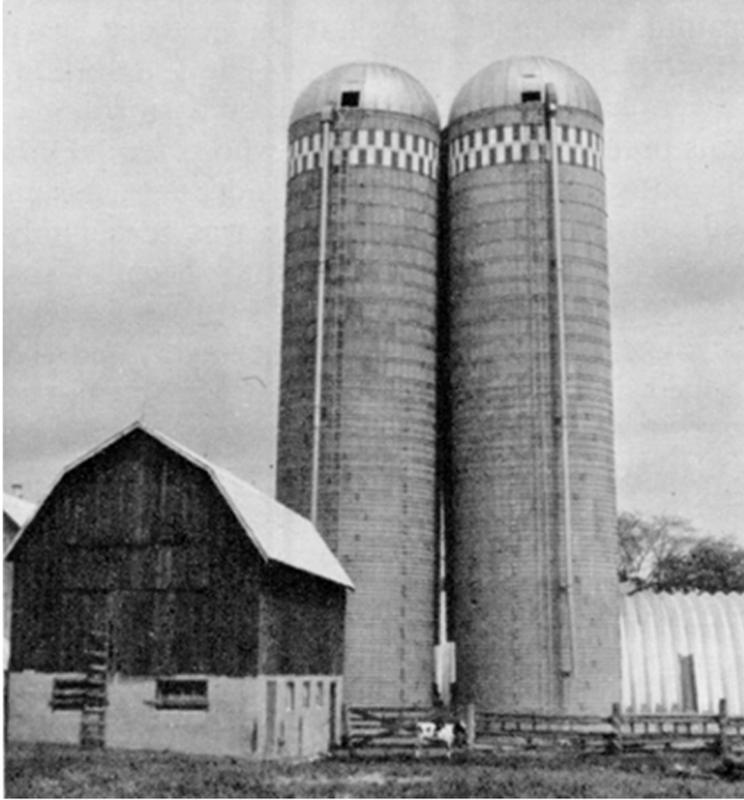
*Figure 3. Silos inclinés l'un vers l'autre à cause d'un tassement non uniforme dans la zone de chevauchement des bulbes de pression.*
