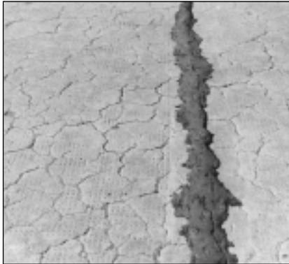
**Figure 2.** Fissuration en faïençage et éjection du matériau de remplissage de joints causée par l'expansion du béton soumis à la réaction alcalis-carbonate dans un trottoir de Kingston (Ontario)
