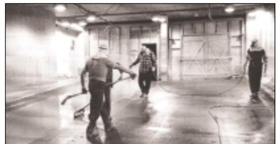
Figure 1. Application d'un revêtement d'étanchéité élastomérique par pulvérisation et roulage
