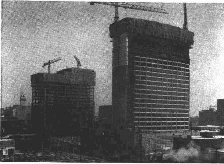
Figure 3 *Vingt-quatre étages d'un hôtel d'Ottawa construits en 12 semaines en hiver*
