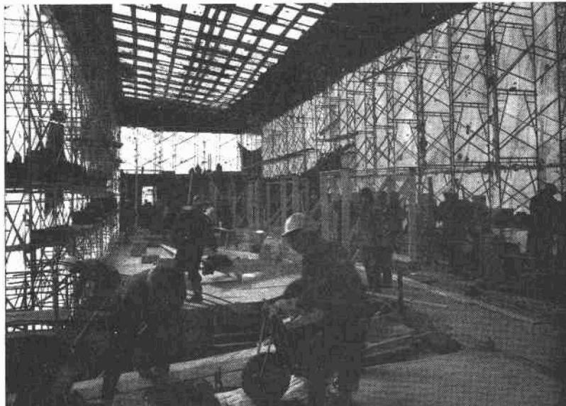
Figure 2 *Travaux de maçonnerie à l'intérieur d'une enveloppe protectrice.*
